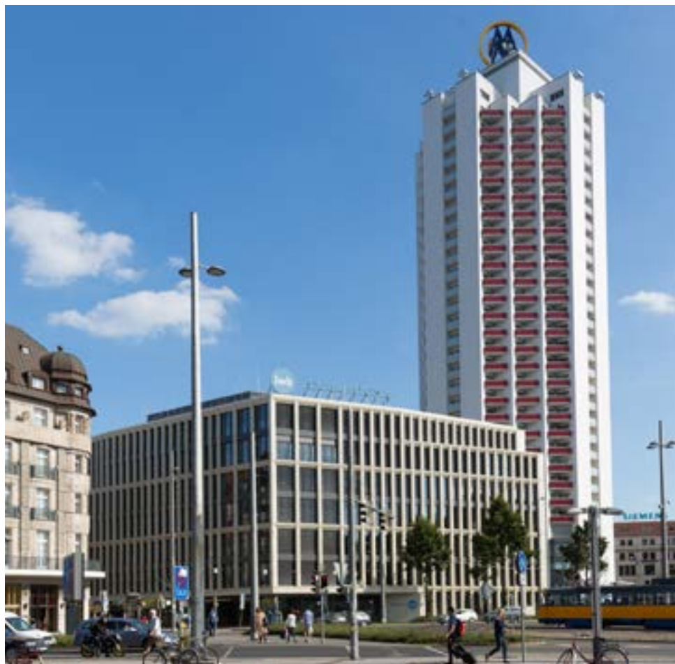
Firmensitz der Leipziger Wohnungs- und Baugesellschaft in der Wintergartenstraße 4
