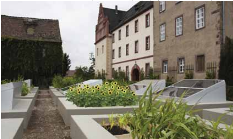
Ein Solar-Luft-System zur Erwärmung von Gebäuden mit extrem großer Speichermasse entwickelten Wissenschaftler der HTWK Leipzig für das Schloss Trebsen
