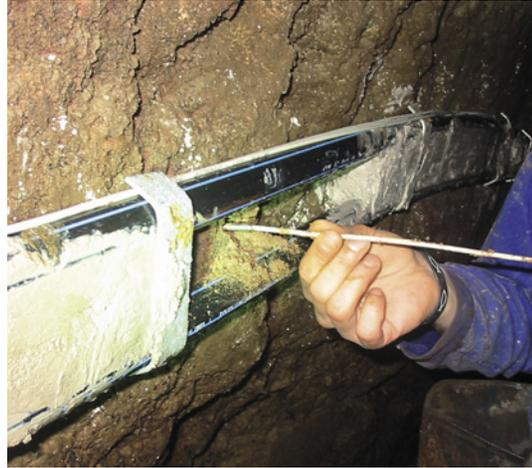
Der Wärmeübertrager kann etwa in Abwasserkanälen,
