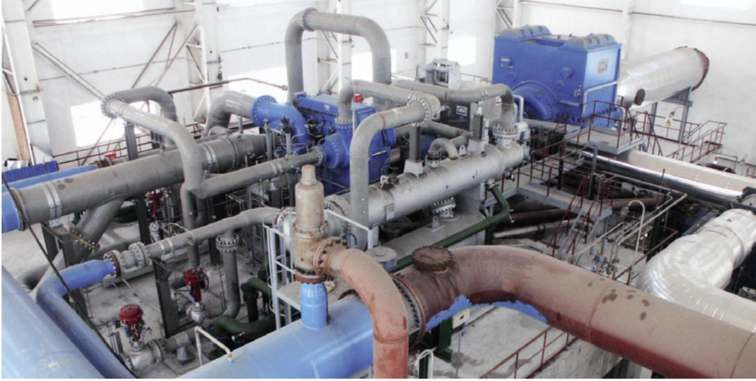
Ohne Verdichter geht in vielen Industriebranchen nichts: Hier der Turbokompressorstrang einer Luftzerlegungsanlage, wie sie zur Herstellung von reinem Sauerstoff oder Stickstoff benutzt wird
