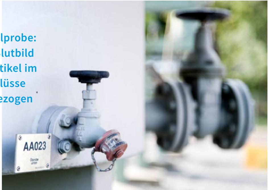
Über den Ölhahn des Trafos können während des Betriebs Proben zur chemischen Untersuchung im Labor entnommen werden
