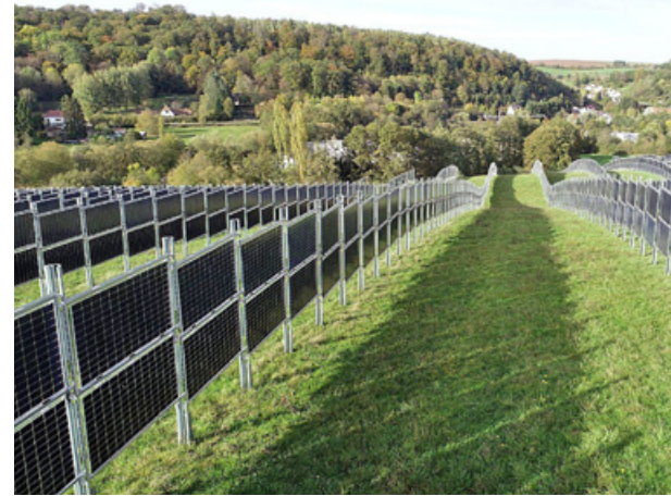
Vertikal installierte, zweiseitige Solarmodule auf einer landwirtschaftlichen Nutzfläche
