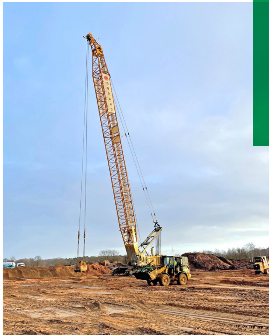
Bei der dynamischen Intensivverdichtung fällt ein 30 Tonnen schweres Gewicht auf den Boden
