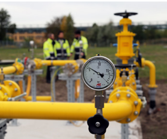
Kann Wasserstoff durch bestehende Kunststoff-Gasleitungen fließen? Das testen HTWK-Forscher im Wasserstoffdorf Bitterfeld-Wolfen
