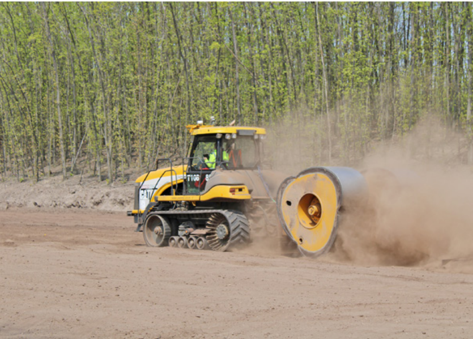
Unrunde Walzen können Böden oberflächennah effektiv verdichten
