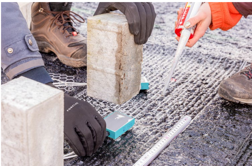
Nach dem Aushärten des Asphalts können die beschwerenden Steine weg
