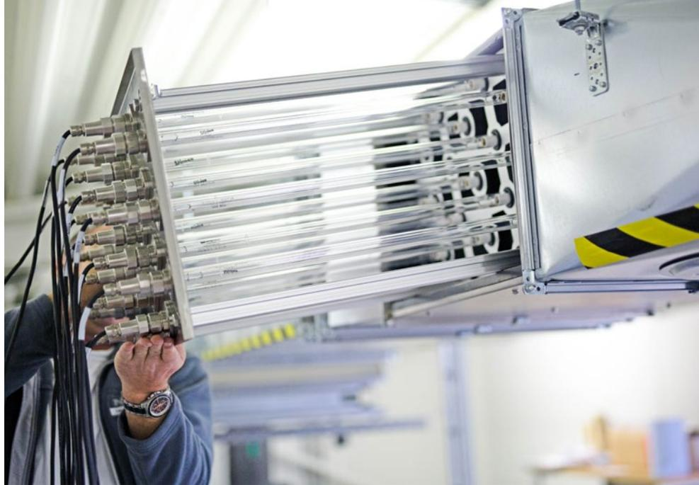
Auch in Lüftungsanlagen können UVC-Strahler intalliert werden und so für eine bessere Hygiene sorgen
