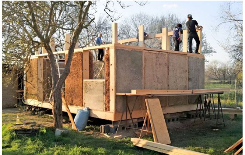
Aus Holz und Stroh entstehen tragfähige Wände
