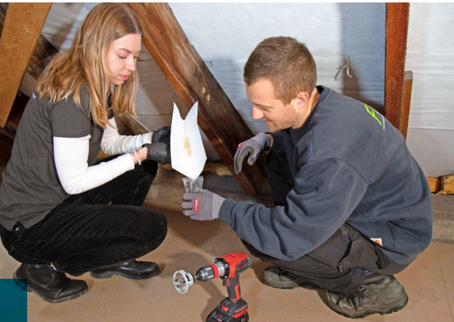
Luisa Sander und Henri von Mulert entnehmen einem Dachsparren Holzproben für die anschließende Schadstoffanalyse
